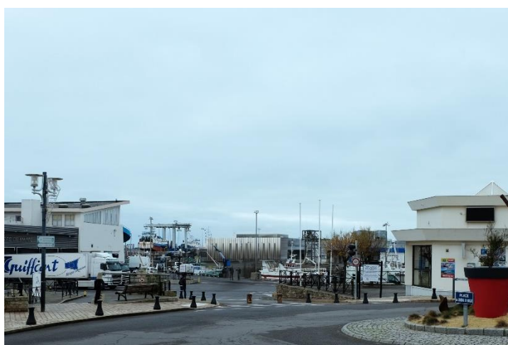
Insertion du bâtiment: Vue de la place du Général de Gaulle
